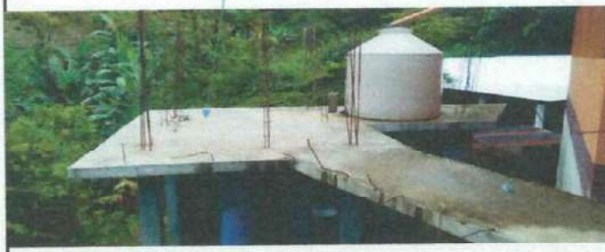
Foto 6: Reconstruir Cocina en Segundo Nivel.
