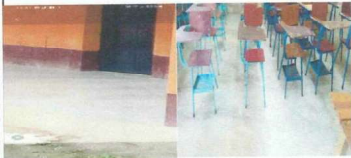
Foto1: Cambio de Piso a piso cerámico.
